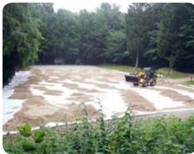
328 Tonnen Sand werden herangeschafft, um den Reitplatz in einen turnierreifen Beachvolleyballplatz umzuwandeln ...
